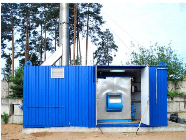
Транспортируемый комплекс термического обезвреживания отходов КТО-50К20Мед - в габаритах 20-фт. контейнера 50 кг/час)
